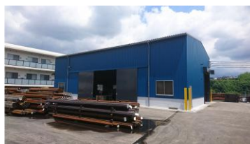
完成した新工場。不回転材や要廃棄物が無くなり工場敷地内の整理整頓が進んだ。
